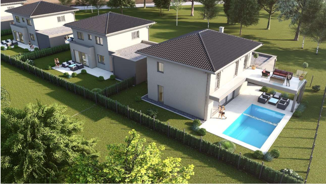
Außenansicht Süd bei Tag
