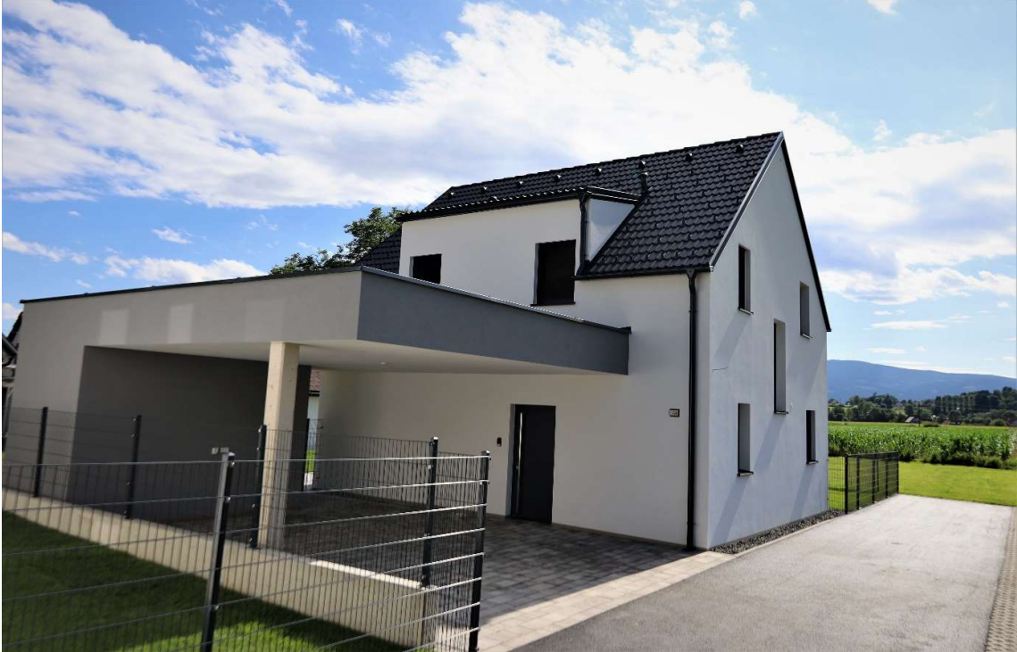
Nordseite mit überdachtem Stellplatz für 2 PKW
