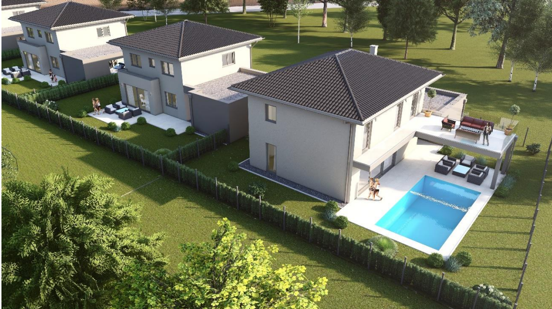
Außenansicht Süd bei Tag
